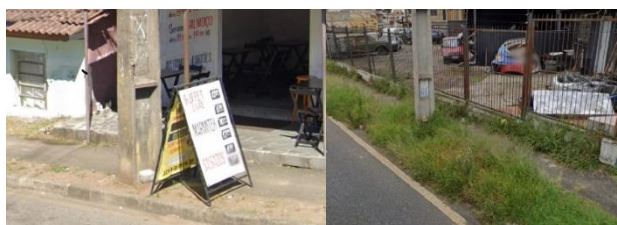
Figura 21. Placa, poste e vegetação excessiva interditando o trânsito em Passeio Compartilhado
