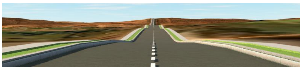
Figura 25 - Defeito de concordância tridimensional de “Abaulamento” no Km 186
