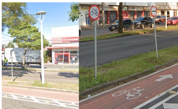
Figura 3. Poste de iluminação direcionada e sinalização vertical e horizontal
