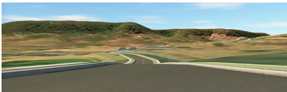
Figura 26 - Defeito de concordância tridimensional de “Mergulho raso” no Km 201
