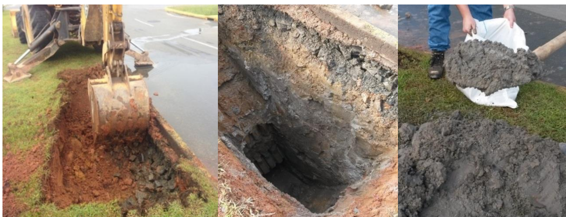
Figura 2 – Poço de sondagem e coleta de amostras no local de implantação do terminal
